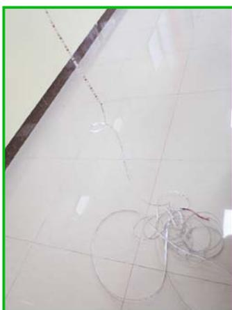
Quando instalar as fitas de LED, não desenrole toda a fita da bobina pois corre o risco da fita se enrolar, vergar ou ser pisada.
